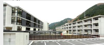
上鳴子住宅建替事業 住宅建設工事(JV)
