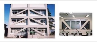
大崎市役所本庁舎 耐震補強工事
