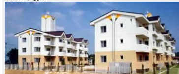
大崎市(三本木) 混内山住宅建替建築工事
