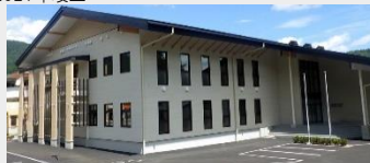
大崎市鳴子総合支所 複合施設 建築工事
