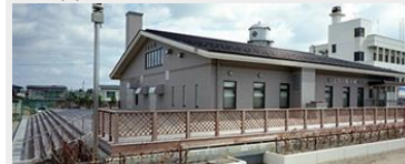
大崎市長古川配水場 建設工事
