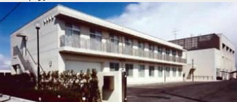
宮城県総合福祉センター新築工事
