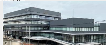
大崎市役所 本庁舎新築工事 (建築・JV)
