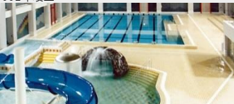
大崎市(古川市)プール等 スポーツ施設新築工事 (JV)
