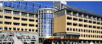
宮城県古川合同庁舎 新築工事 (JV)
