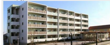
大崎市古川地域災害公営住宅整備事業 七日町住宅建設工事
