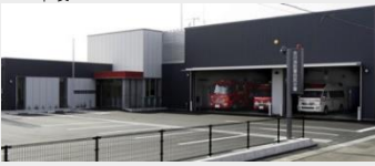
古川消防署田尻分署庁舎等 建設工事 (建築)
