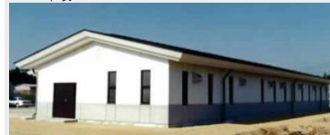
美里町南郷第一地区(農集排) 処理施設建設工事
