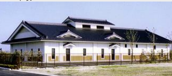
大崎市飯川地区 農集排1号処理場建設工事
