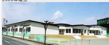
美里町立南郷幼稚園・保育所 建築工事
