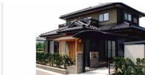
個人様邸宅 新築工事
