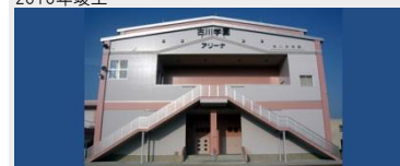
学校法人古川学園 第二体育館新築工事
