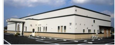
葬祭会館 葵 新築工事
