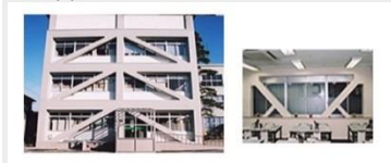
大崎市役所本庁舎 耐震補強工事
