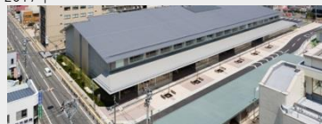
大崎市図書館等複合施設建設工事(JV) 外構
