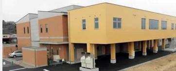
大脳市民病院岩出山分院 リハビリテーション施設増築工事（建築）
