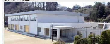
大崎市立鹿島台小学校 屋内運動場改築工事
