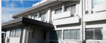
高橋医院 外壁改修工事
