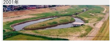
新江合川古川福沼地区工事
