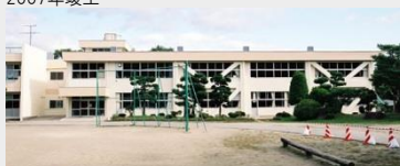
大崎市立川渡小学校 校舎耐震補強及び大規模改修工事
