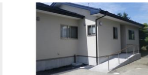
個人様邸宅 新築工事（設計・施工）
