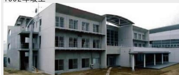
宮城県農業実践大学校 農産学部新築工事（その3）
