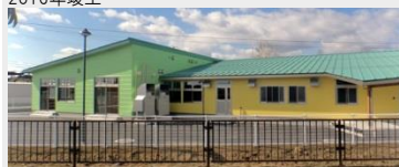
松山幼保一元化施設 建設工事（建築）
