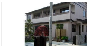
個人様邸宅 新築工事（設計・施工）
