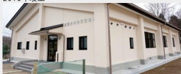
大崎市立鹿島台中学校 武道場改築工事
