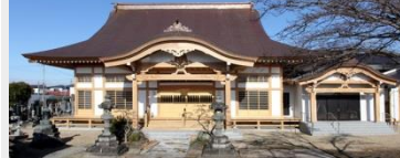
雲谷山龍洞院 本堂等新築工事
