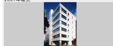
学校法人菅原学園 仙台ビジネス専門学校増築工事
