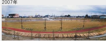
大崎市 古川南地区公園修景施設工事
