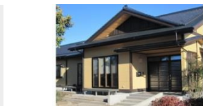
個人様邸宅 新築工事（設計・施工）
