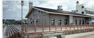
大崎市上古川配水場 建設工事
