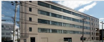
大崎市役所東庁舎 改修工事
