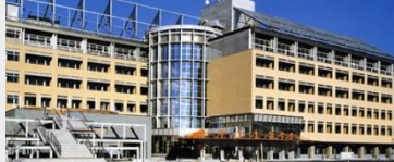
宮城県古川合同庁舎 新築工事（JV）
