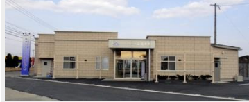
JA古川 通夜会館・斎場建設工事
