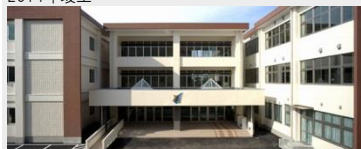
学校法人古川学園 高校校舎新築工事
