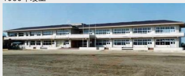
大崎市立宮沢小学校 校舎及び給食室新築工事
